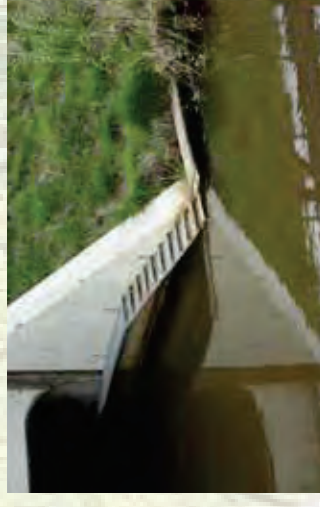
Kleine, niet zwemmende dieren en amfibieën gebruiken de eco-duiker met een droge looprichel om de weg veilig over te steken.
