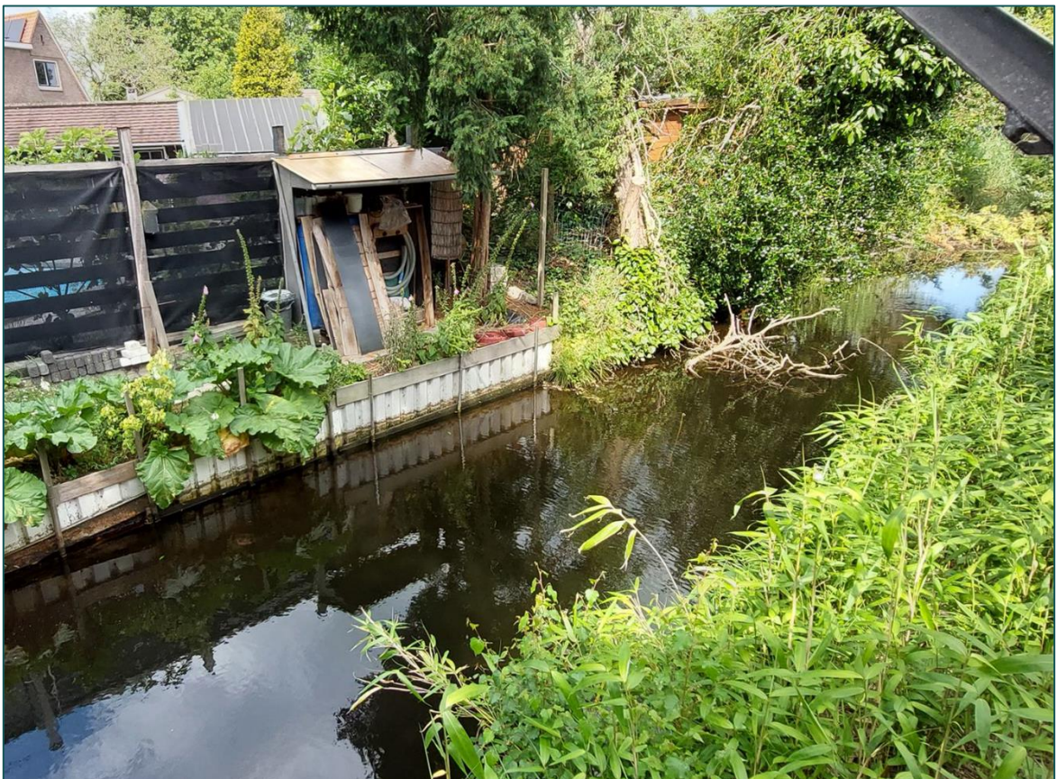
Figuur 4 De watergang ten westen betreft het Luye Gat met beschoeide oevers. Hier worden mogelijk natuurvriendelijke oevers gerealiseerd.
