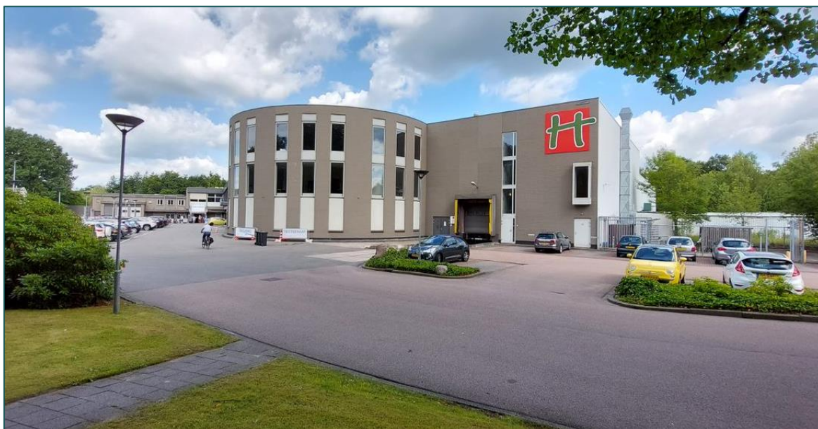
Figuur 1 De planlocatie is gelegen aan de Franse Kampweg e.o. te Bussum en bestaat uit een bedrijventerrein met het distributiecentrum van de voormalige Hocras.
