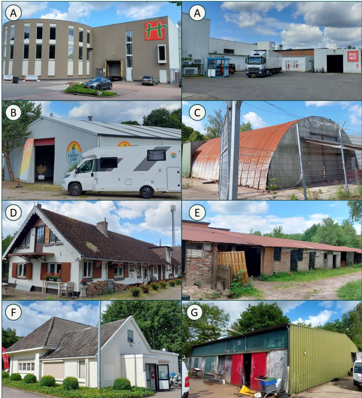
Figuur 1.3 Op de planlocatie is men voornemens om de volgende gebouwen te slopen.
