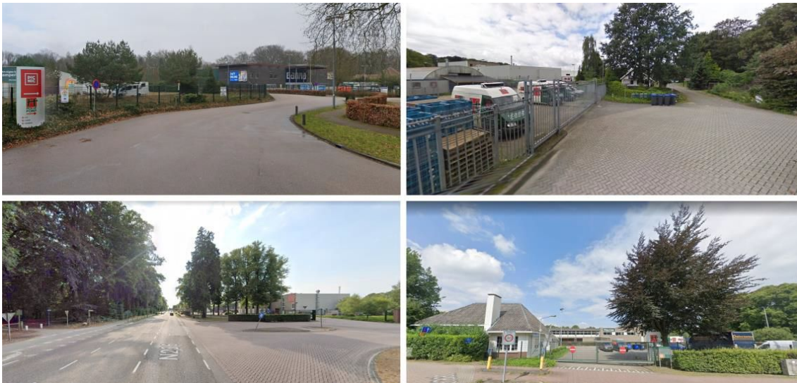
Foto's over de ligging en de bestaande situatie van het terrein
