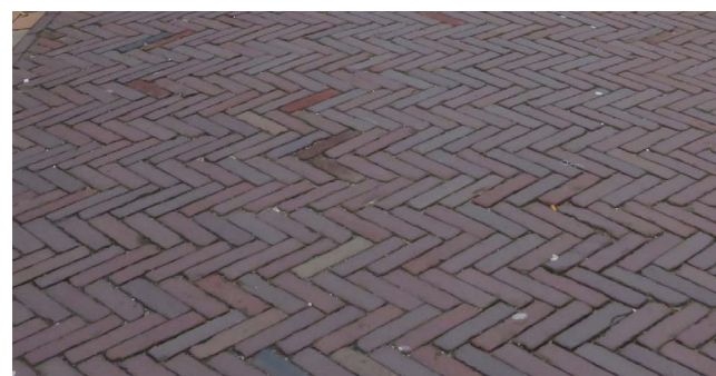
Uitstallingszone, straatbaksteen donker (hergebruik), elleboogverband
