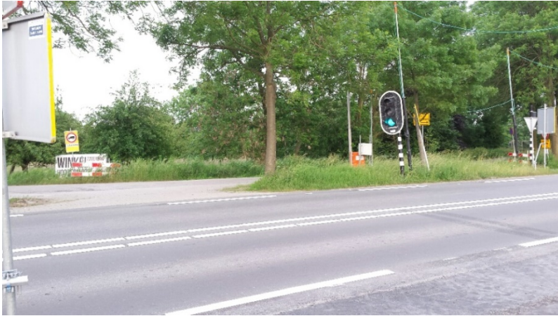
Foto van de aansluiting van de Weesperbinnenweg op de Weesperweg met direct ten zuiden daarvan de verkeersregelinstallatie ten behoeve van de geregelde fietsoversteek (opnamedatum 7 juni 2016).
