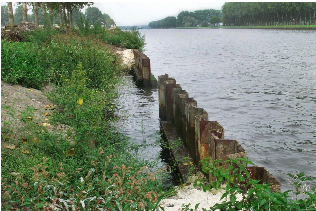
figuur 3.2: fauna-uitreideplaats langs het Amsterdam-Rijnkanaal. (bron: Jaarverslag 2018 Meerjaren ontsnipperingsprogramma).
