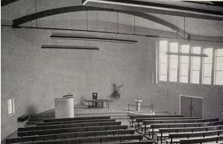
Afb. 17 Interieur van de kerkzaal met de inrichting en de trekspanten voor de overspanning van de zaal (Forum 1/2, 1957).
