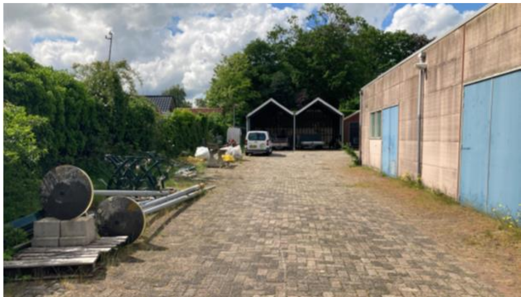
Aan de linkerkant het bedrijfsgebouw op de gemeentewerf, aan de rechterkant de afscheiding ten opzichte van de recreatiewoningen.
