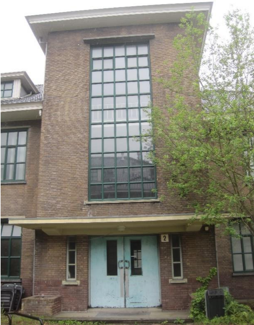
Figuur 45. Voorportaal gebouw 2.
