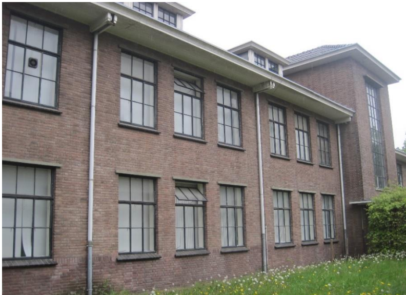
Figuur 42. voorzijde gebouw 3.
