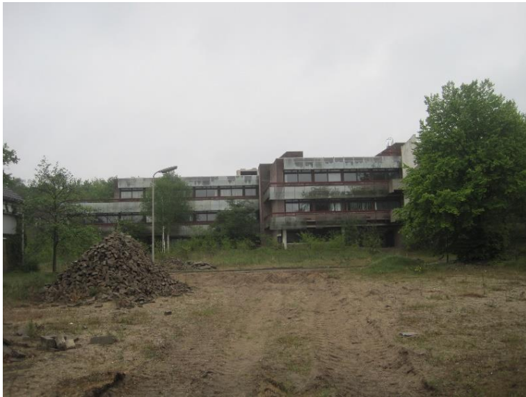
Figuur 60. Gebouw Spiegelhorst voorkant.
