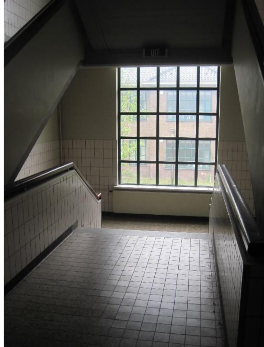
Figuur 44. Trappenhuis gebouw 2.
