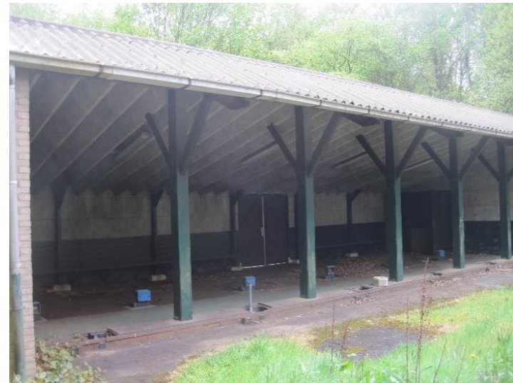
Figuur 90. Kapschuur schietbaan.
