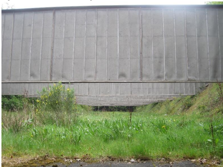
Figuur 92. Kogelvanglers van de schietbaan.
