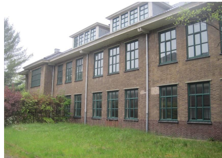
Figuur 43. Achterzijde gebouw 2.
