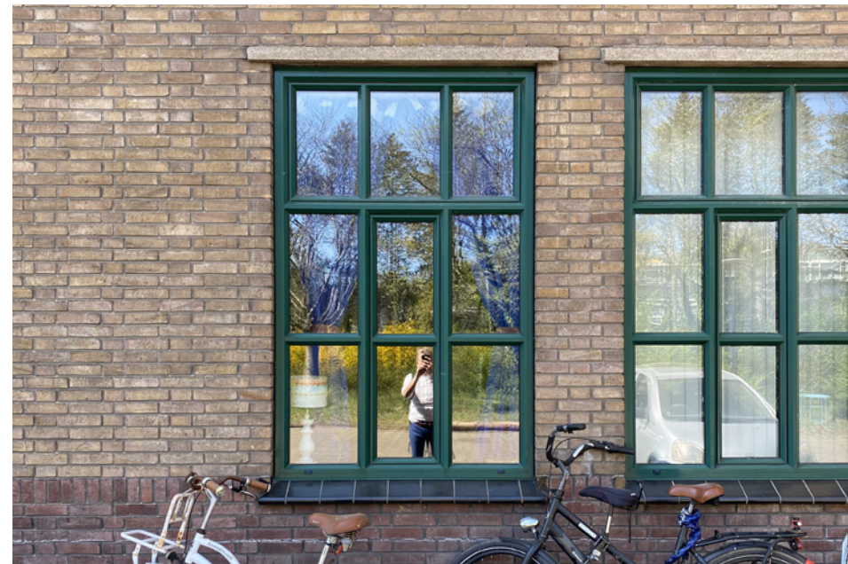
Groene kunststof kozijnen geplaatst ter vervanging van de oorspronkelijke stalen kozijnen
