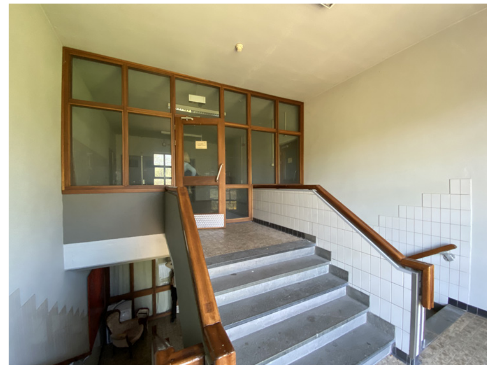
Later aangebrachte brandscheidingen tussen de gangen en de trappenhuizen, 2020
