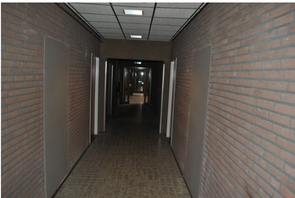
De gang met wanden in schoon metselwerk
