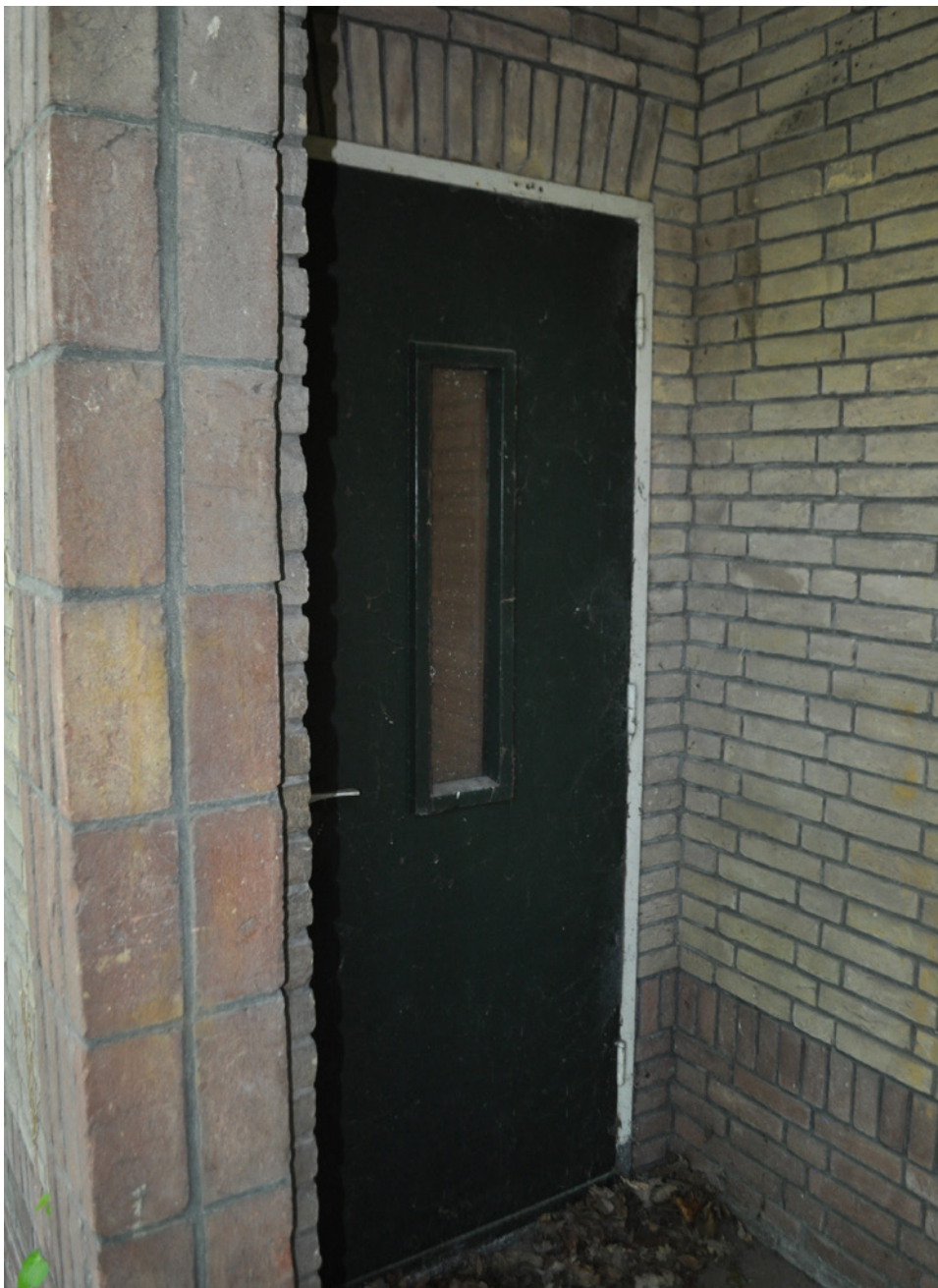
Ingang achterzijde gebouw 7
