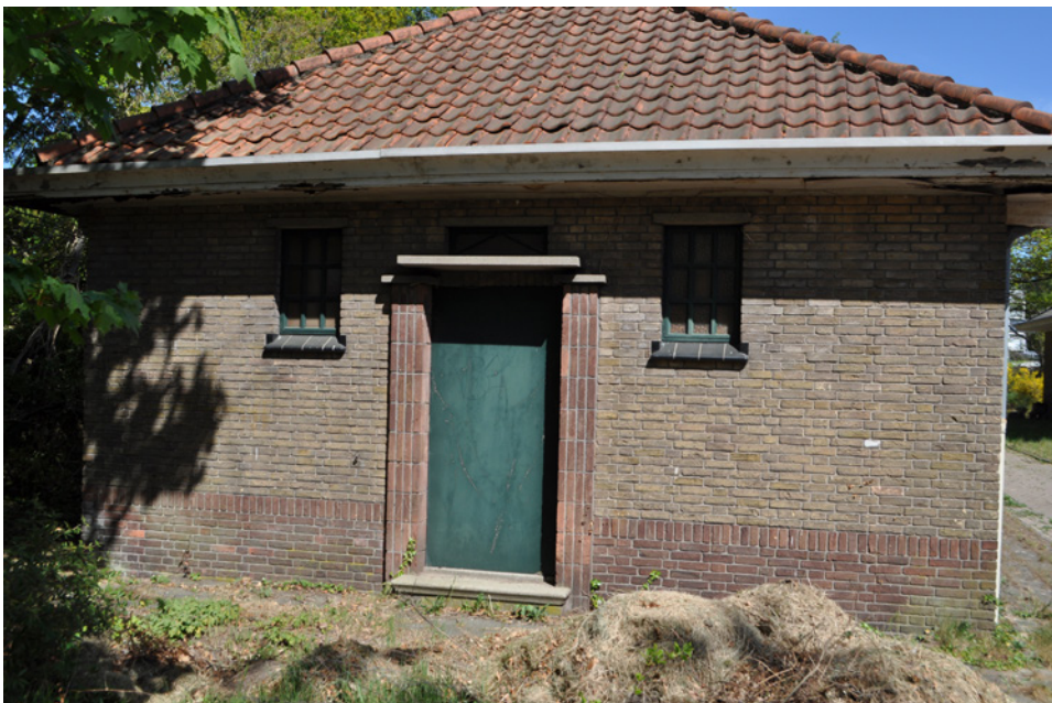
Kopgevel, entreepartij met bovenlicht
