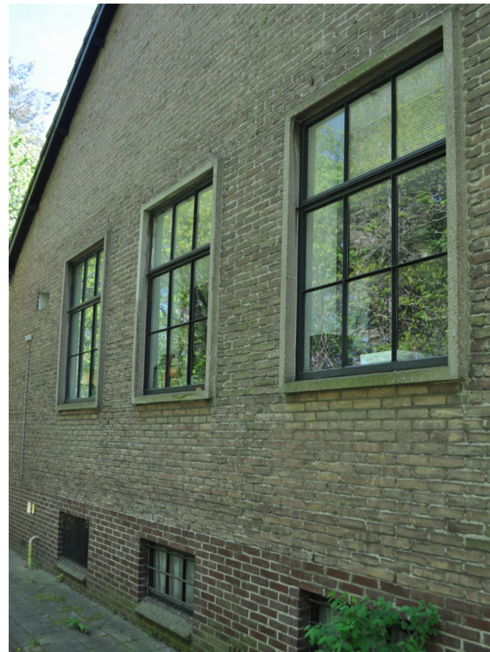
Ramen in de noordelijke kopgevel met betonnen kozijnen
