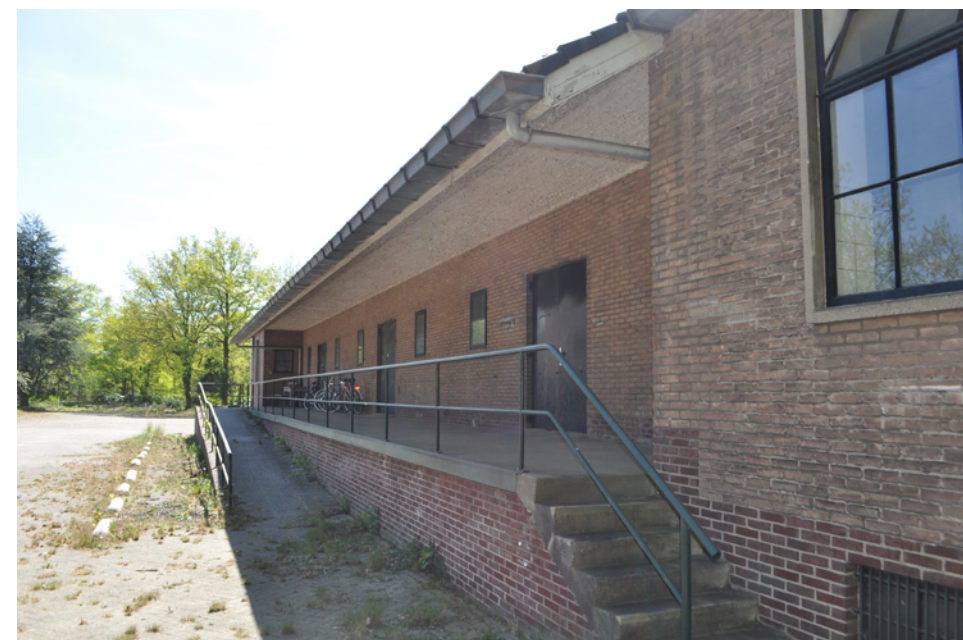
Laadperron aan de oostgevel
