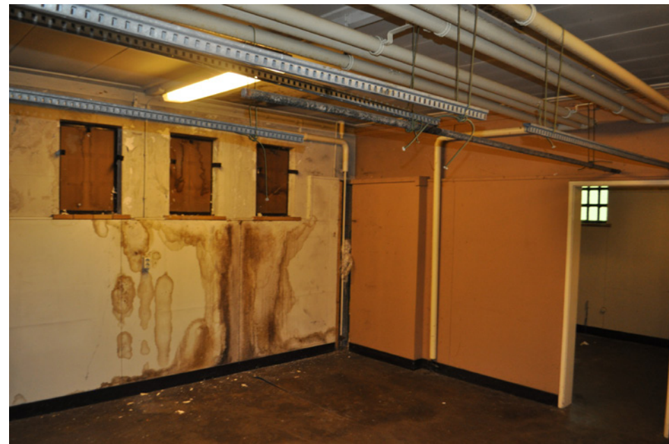
Het oorspronkelijke interieur is uitgebroken
