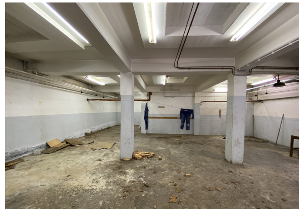
Interieur van de voormalige kolenkelder. Let op de sparingen voor de daklichten die later met beton zijn dichtgemaakt
