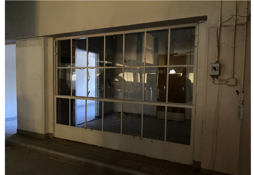
Stalen kozijnen in het keukengebouw
